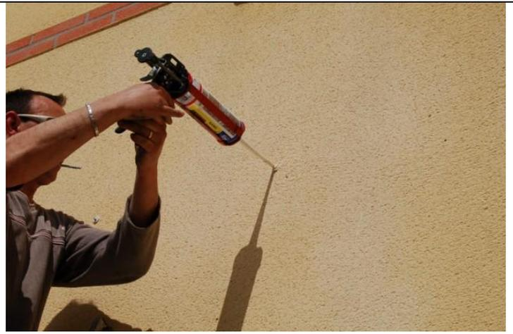
Dans un mur brique ou béton nous vous conseillons de réaliser un scellement chimique (en option).
