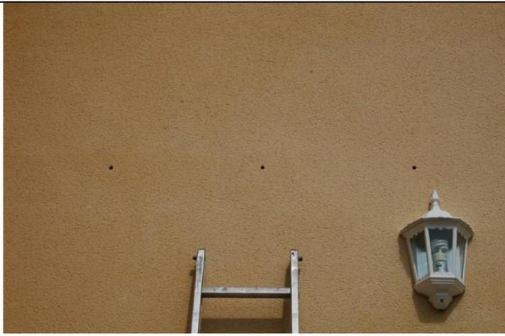
Faire les perçages adaptés suivant votre support, une tige filetée M6\*100mm est fournie avec chaque piton à œil, la résistance de la fixation doit être suffisante pour supporter la tension des câbles (environ 250 kg)
