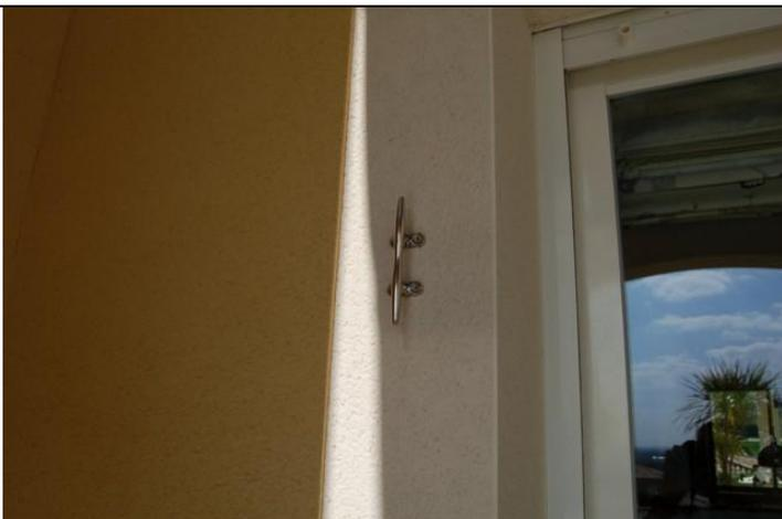
Fixer au mur le taquet servant à attacher le cordage de manœuvre.
