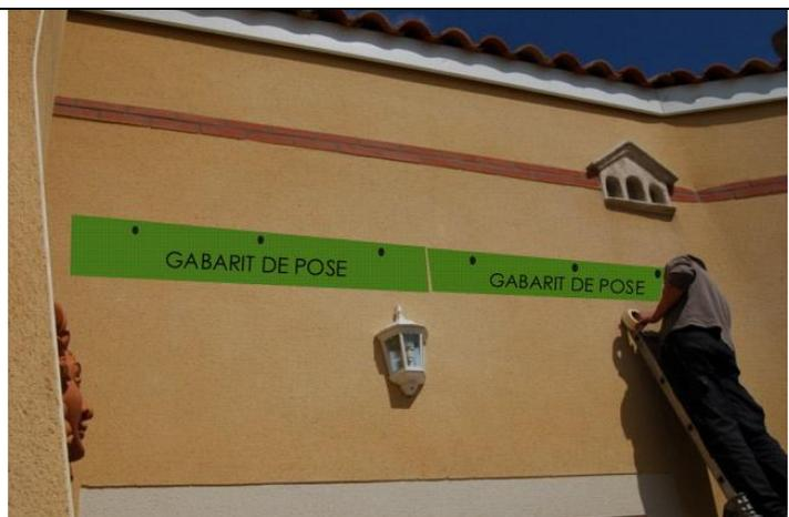
Répéter l'opération pour l'ensemble des modules(3 perçages pour chacun). Le gabarit représente le format du système une fois replié.
