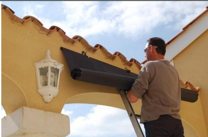
Placer la toile côté fixe et la visser au mur avec les pitons à œil.
