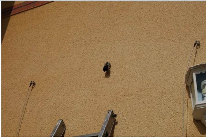
Visser les pitons à œil déjà sertis sur les câbles, sur le piton central placer la poulie recevant la corde de manœuvre, mettre la poulie double du côté où vous désirez faire descendre la corde.
