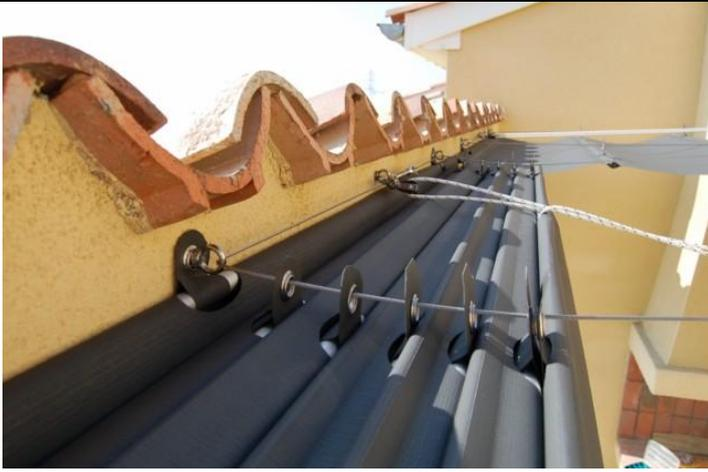
Détail du passage des câbles dans les passants et pitons, tendre le tendeur afin qu'il n'y ait plus de flèche au niveau des câbles.
