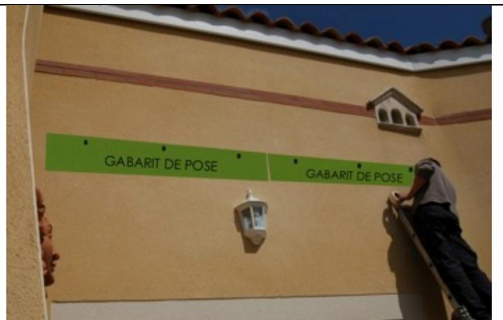
Répéter l'opération pour l'ensemble des modules (3 perçages pour chacun). Le gabarit représente le format du système une fois replié.
